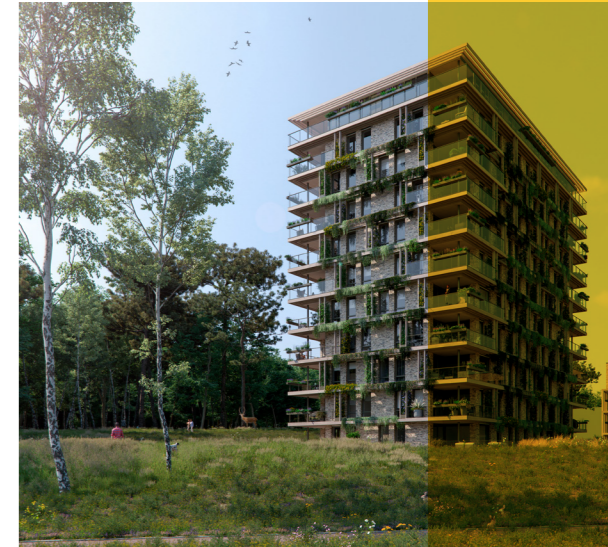
Veluwe Proeftuin fase 1 is verkocht en in aanbouw
